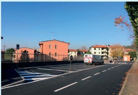
ta la via è stata oggetto di una scarificazione della pavimentazione esistente. Il marciapiede esistente si è rifatto completamente il look: la pavimentazione preesistente è stata rimossa. Sono stati dunque posati nuovi cordoli e ricollocata l'asfaltatura. Si è infine provveduto a realizzare un'aiuola e sono stati posizionati i nuovi pozzetti stradali per la raccolta di acque meteoriche.
